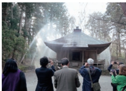
国連防災会議エクスカーション一行来山 経蔵では、ドレンチャーを起動してのデ モンストレーションが行われた。(3月19日)
