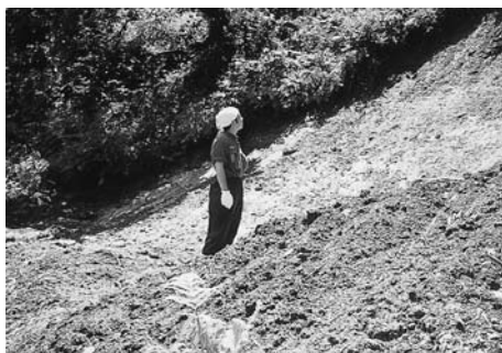
6月1日夕刻の局地的大雨で 東物見台下の斜面が大きく崩れた
